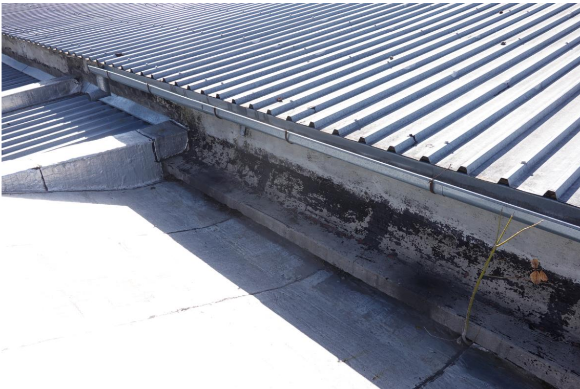
Foto 5. Retirar vegetales, hidrolavado, reparación de superficies, aplicación de membrana líquida PU + geotextil.
