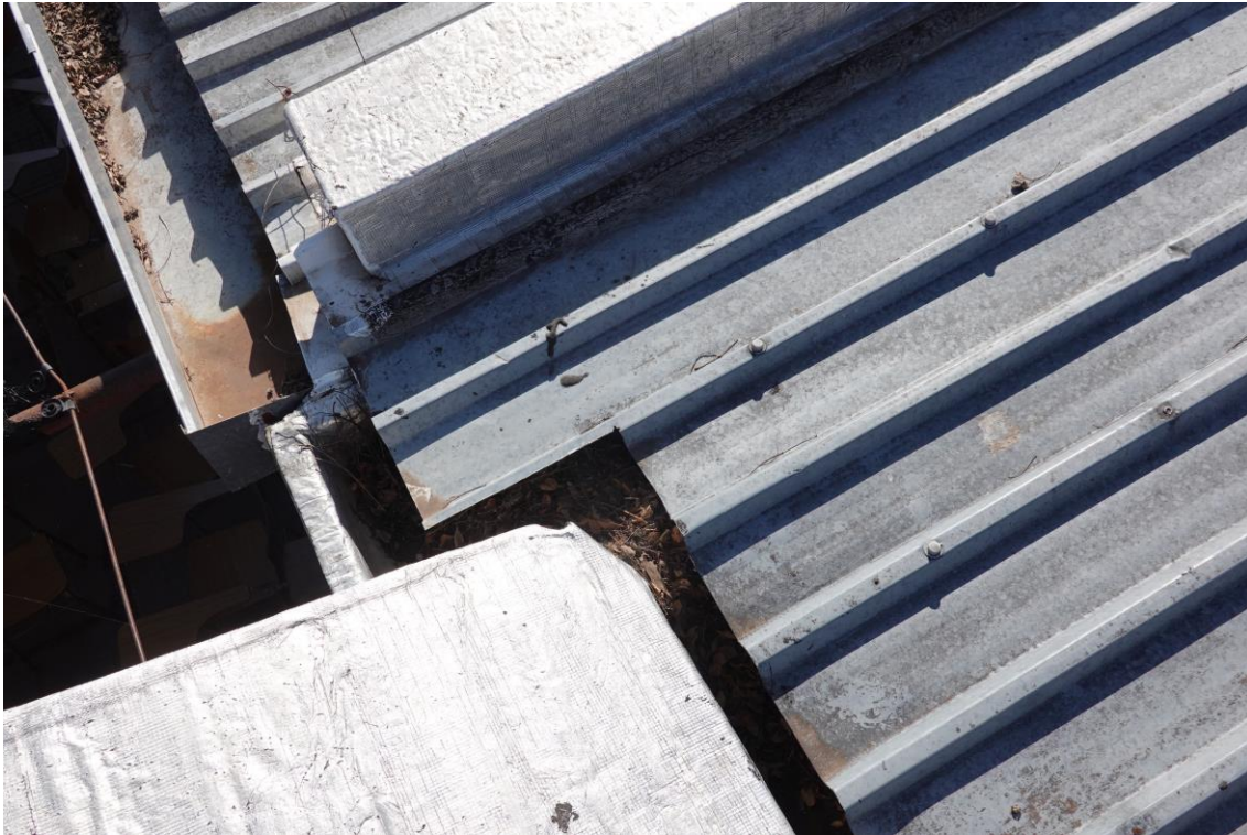
Foto 6. Recortar chapa, limpieza de canalón y reimpermeabilización del mismo..
