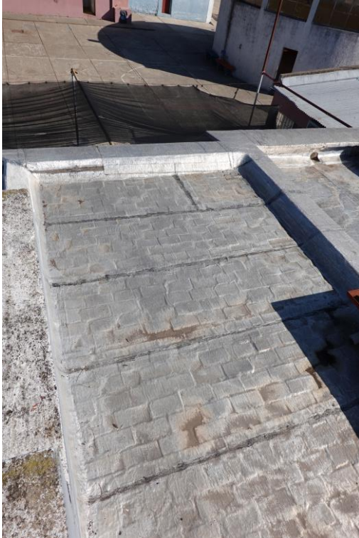
Foto 7. Cubierta 3. Retiro de membrana existente y colocación de membrana asfáltica.
