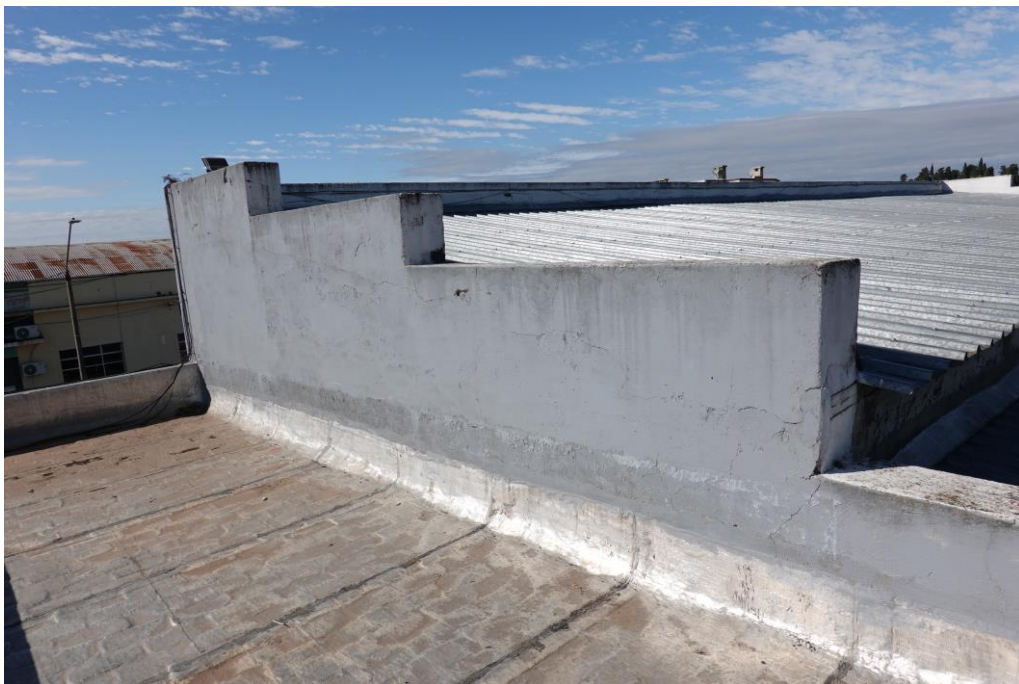
Foto 8. Tratamiento de pretilas. Aplicación de membrana líquida PU + geotextil.
